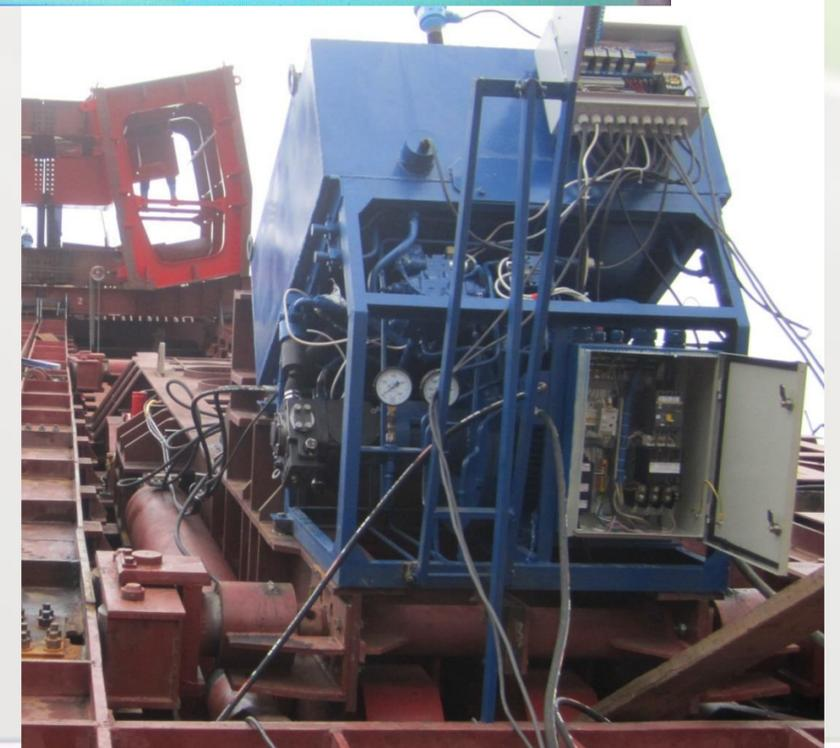
Максимальное усилие надвижки одной ветви полусвода – 390т
