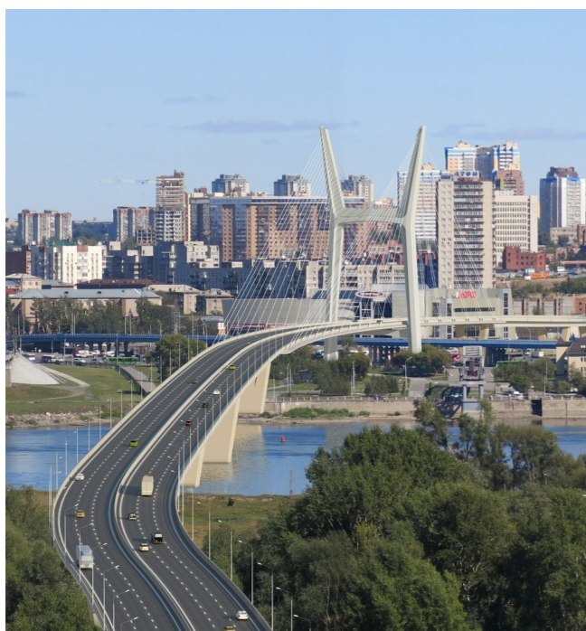
Новосибирск. Мостовой переход через р.Обь
