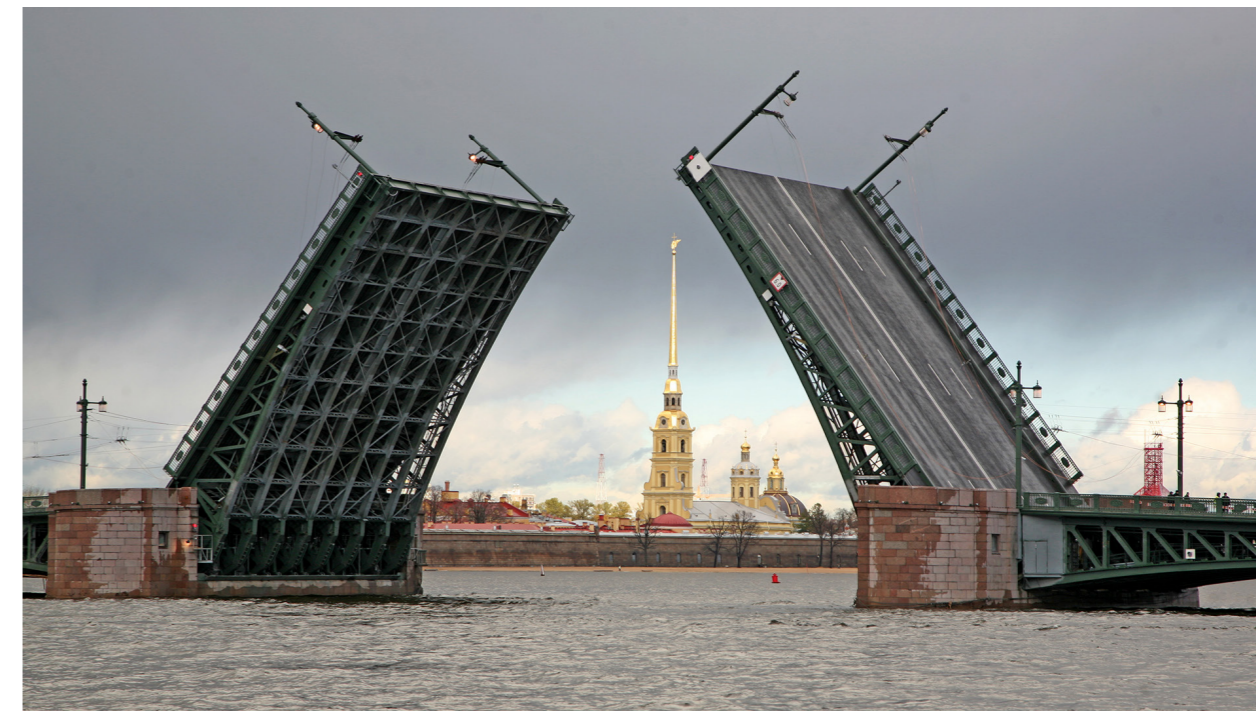
Санкт-Петербург. Реконструкция Дворцового моста.
