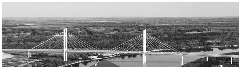
Русловая часть – 650 м Схема (75+120+254+120+74) м
