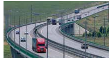
АВТОМОБИЛЬНАЯ ДОРОГА М-4 «ДОН»
