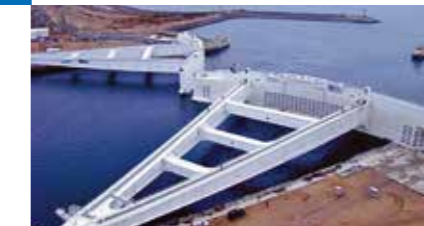
КОМПЛЕКС ЗАЩИТНЫХ СООРУЖЕНИЙ ОТ НАВОДНЕНИЙ САНКТ-ПЕТЕРБУРГ
