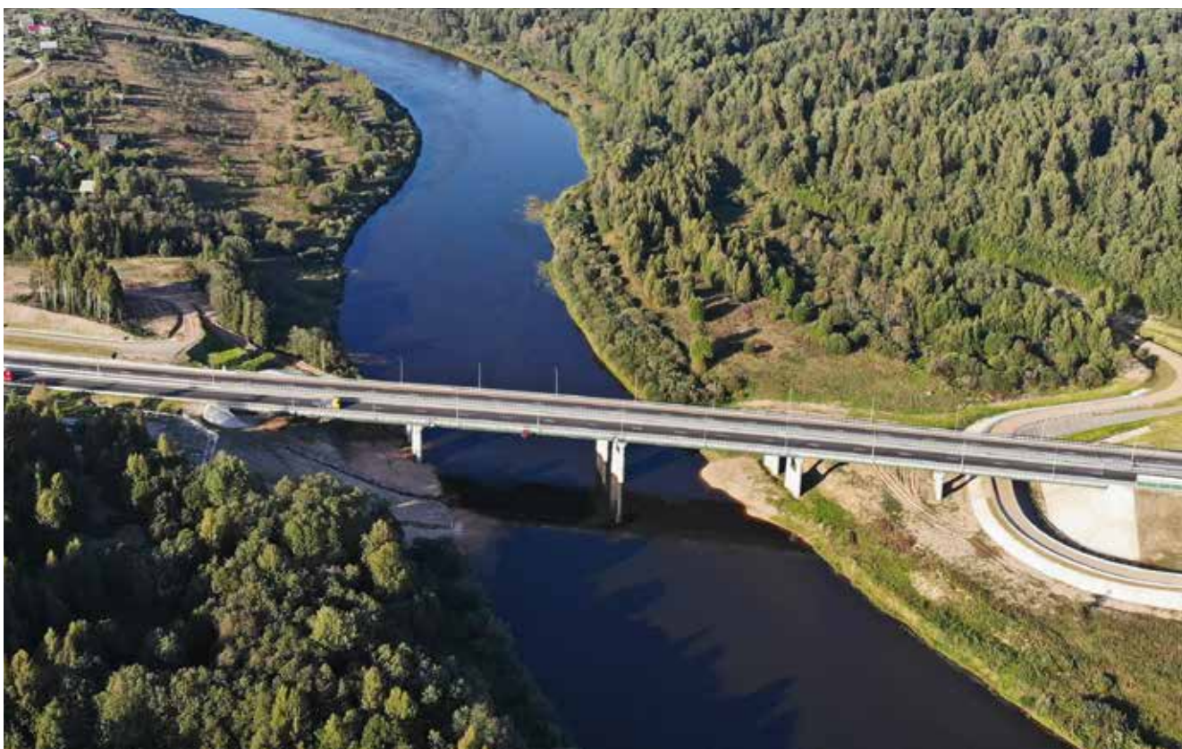
Мост через р. Мсту
