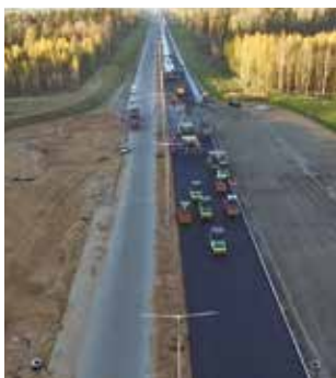
Строительство дороги М-11
