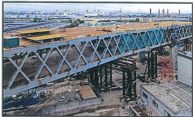
Рис. 75–79. На строительстве 2-й очереди. Монтаж уникальных двухъярусных ферм.
