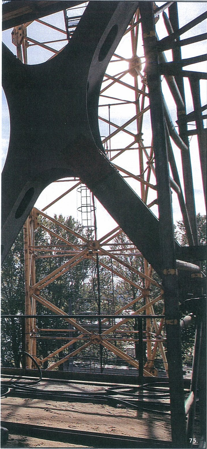
Рис. 75–79. На строительстве 2-й очереди. Монтаж уникальных двухъярусных ферм.
