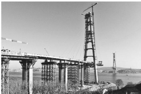
Строительство моста на остров Русский через пролив Босфор Восточный во Владивостоке
