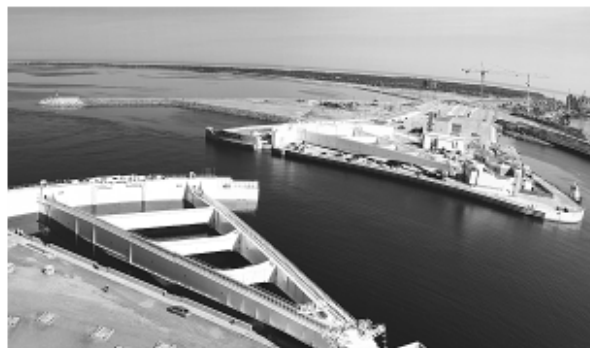
На строительстве Комплекса защитных сооружений Санкт-Петербурга от наводнений
