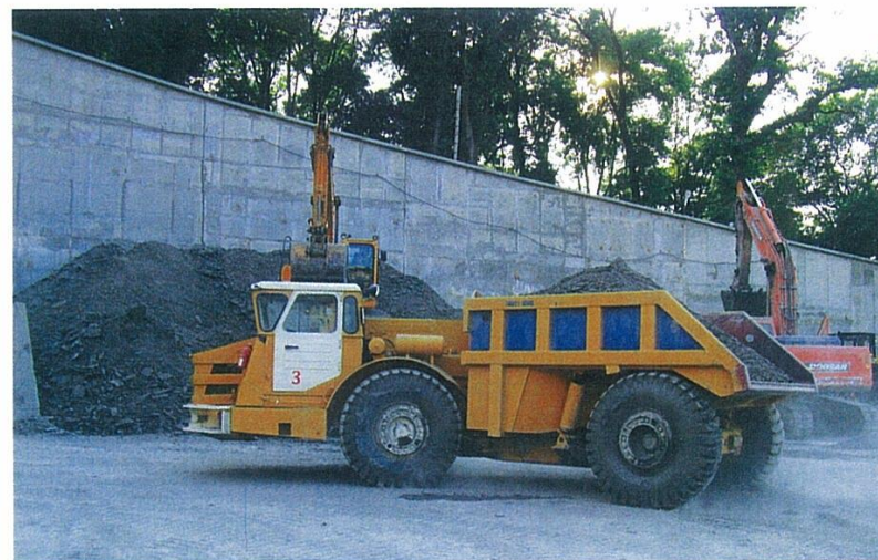
На строительстве тоннелей №5 и 5а
