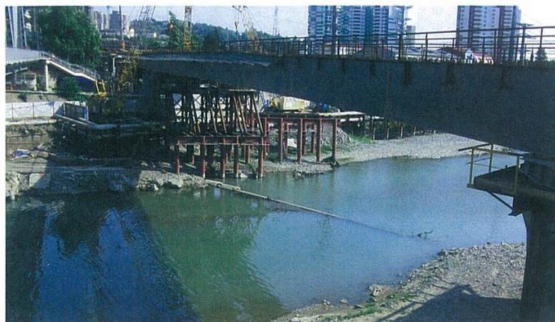
Строительство моста через реку Сочи
