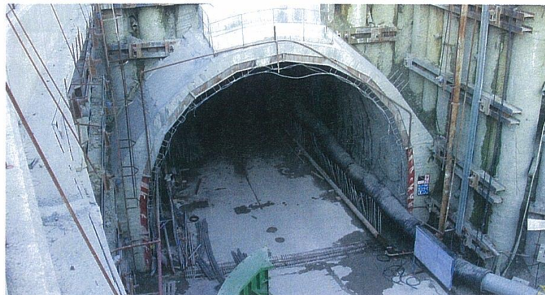
Тоннель №8. Дополнительная штольня
