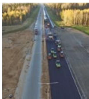
Строительство дороги М-11
