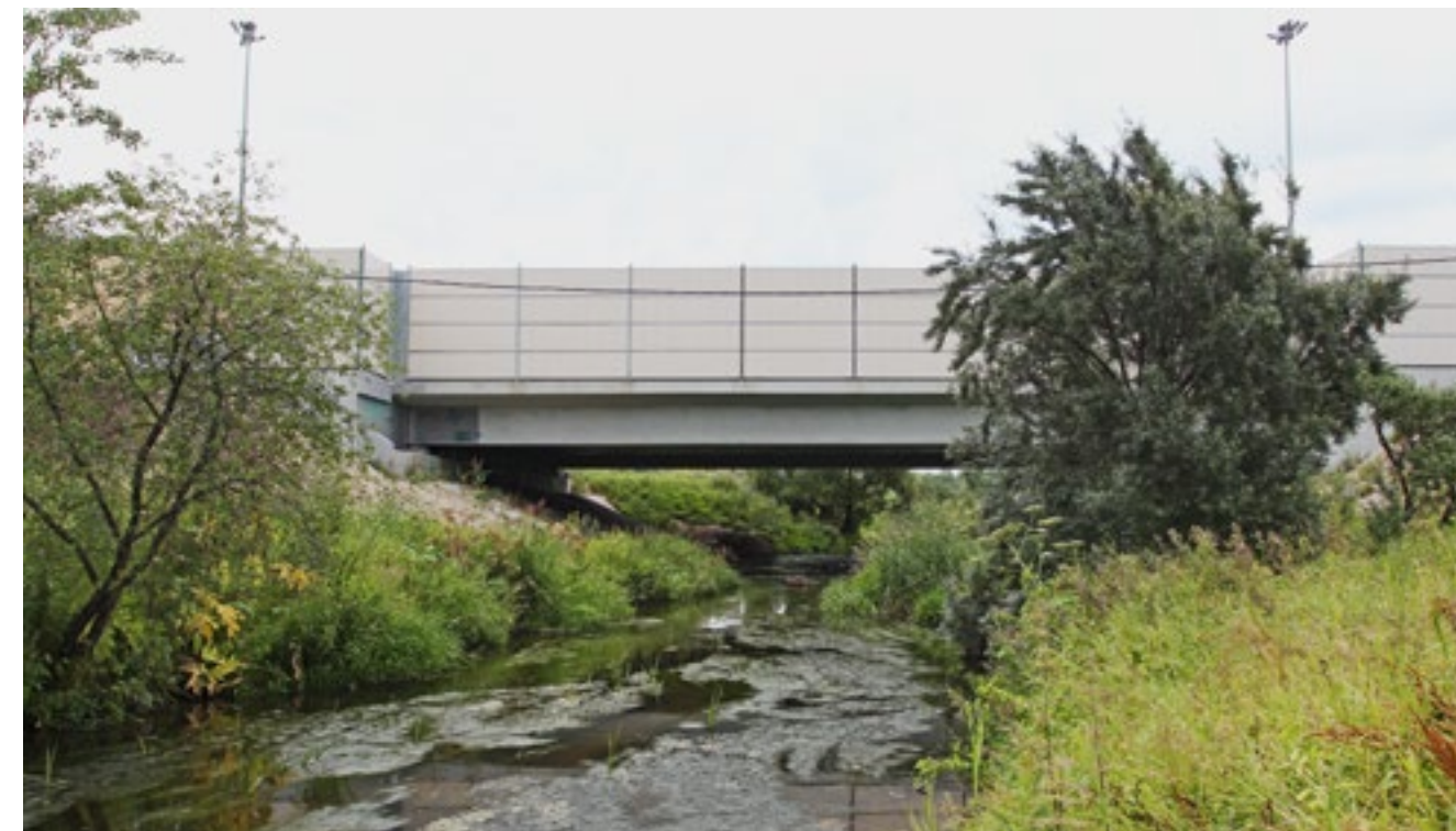
Мост через р. Славянку
